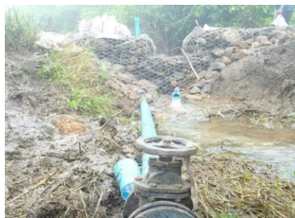
ข) การผันน้ำและการต่อท่อ PVC เพื่อส่งน้ำสู่พื้นที่การเกษตร
